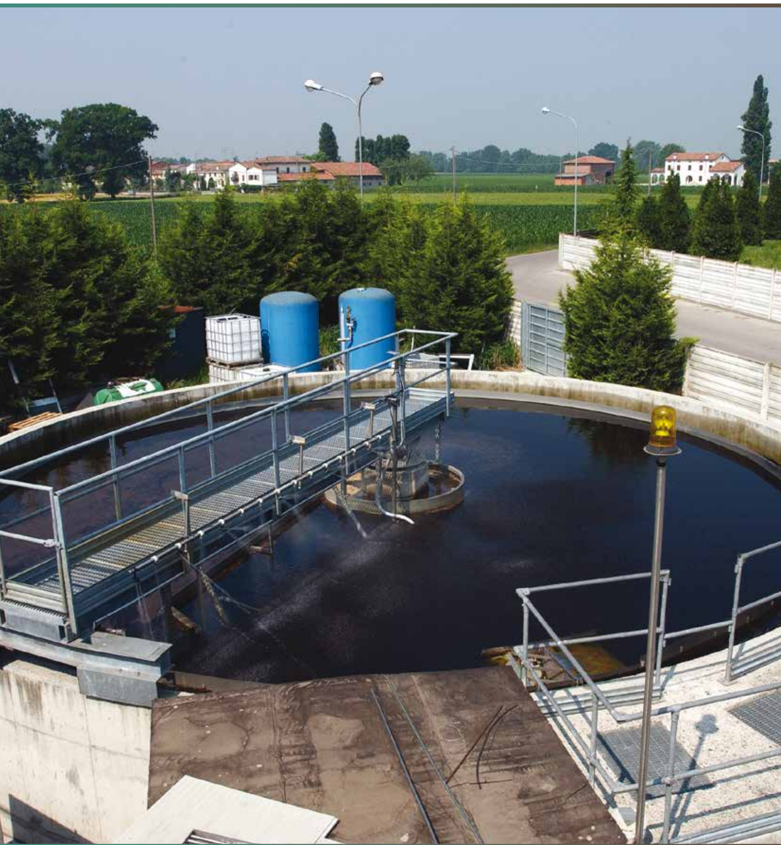
Foto 5.12 Sedimentatore con carroponete Fonte ISPRA Paola Orlandi
