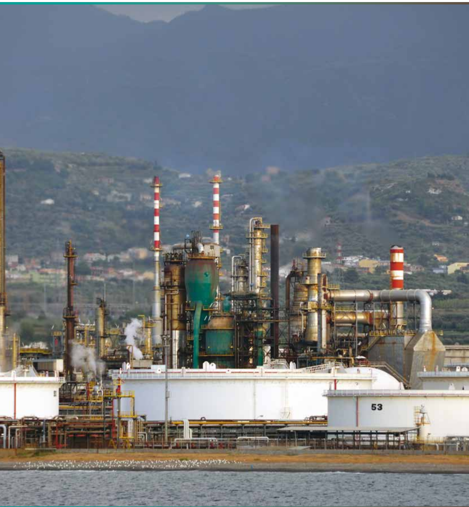
Foto 10.19 Impianti industriali Fonte MATTM Luca Grassi
