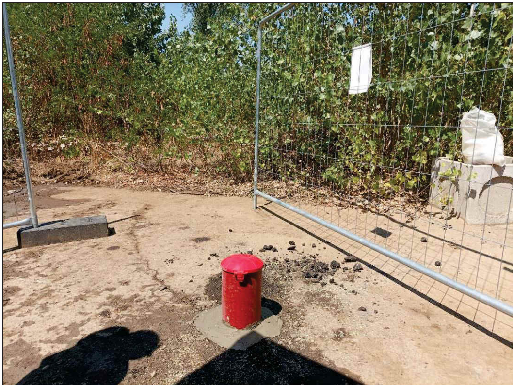
SITUAZIONE AL TERMINE DELL'INSTALLAZIONE DEL PIEZOMETRO
