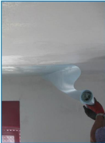
Applicazione del tessuto di armatura MAPEWRAP EQ NET su soffitto
