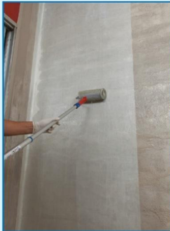
Applicazione del secondo strato di adesivo MAPEWRAP EQ ADHESIVE
