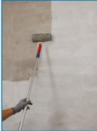
Applicazione del primo strato di adesivo MAPEWRAP EQ ADHESIVE
