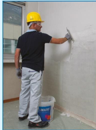
Rasatura con PLANITOP 200
