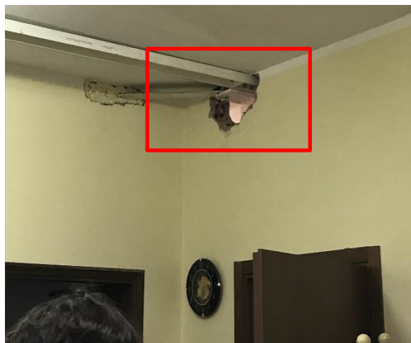
“Locale vigili” al piano terra
