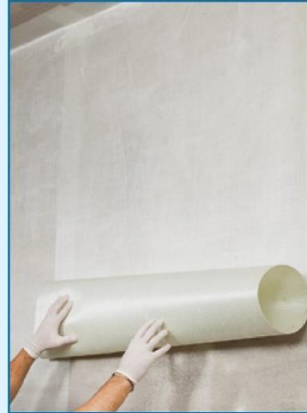
Applicazione del tessuto di armatura MAPEWRAP EQ NET su parete
