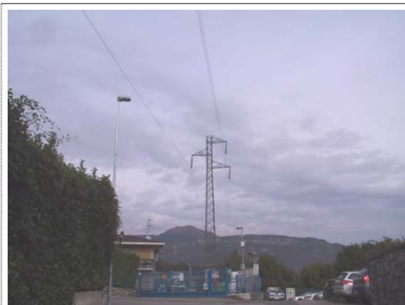
Foto 13: Traliccio della linea ad A.T. 23025D1 in località Pertegalli.
