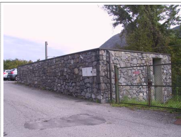
Foto 9: Serbatoio d'accumulo Industriale sito in via delle Fontane.
