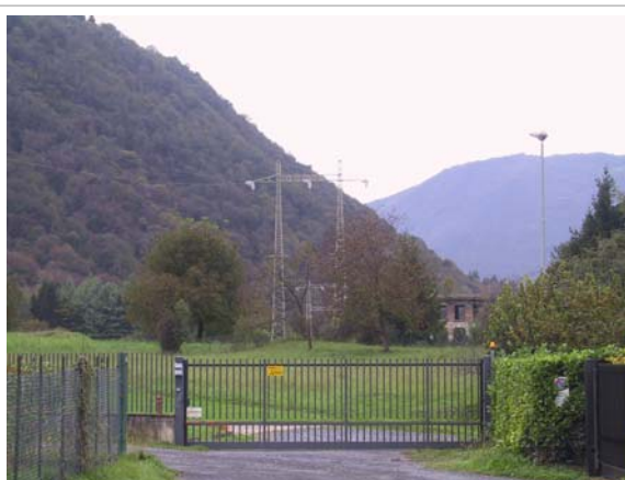
Foto 14: Tralicci della linea ad A.T. 23617A1 in località Valmaggione.
