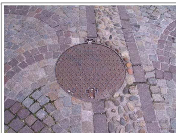
Foto 11: Pozzetto con chiusino in ghisa della rete fognaria lungo via Martiri della Libertà.
