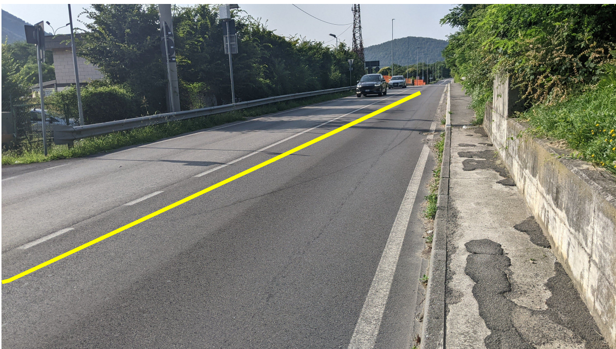
Fig. 3 Via Sardegna: la rete SNAM si sviluppa parallela alla strada a profondità superiore ai 2 m
