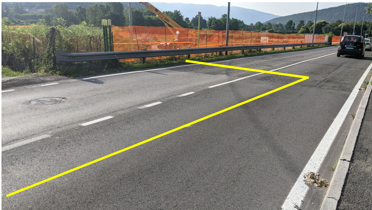
Fig. 2 Via Nicolini: la rete SNAM arriva da est, devia di 90° e prende l'allineamento con la strada
