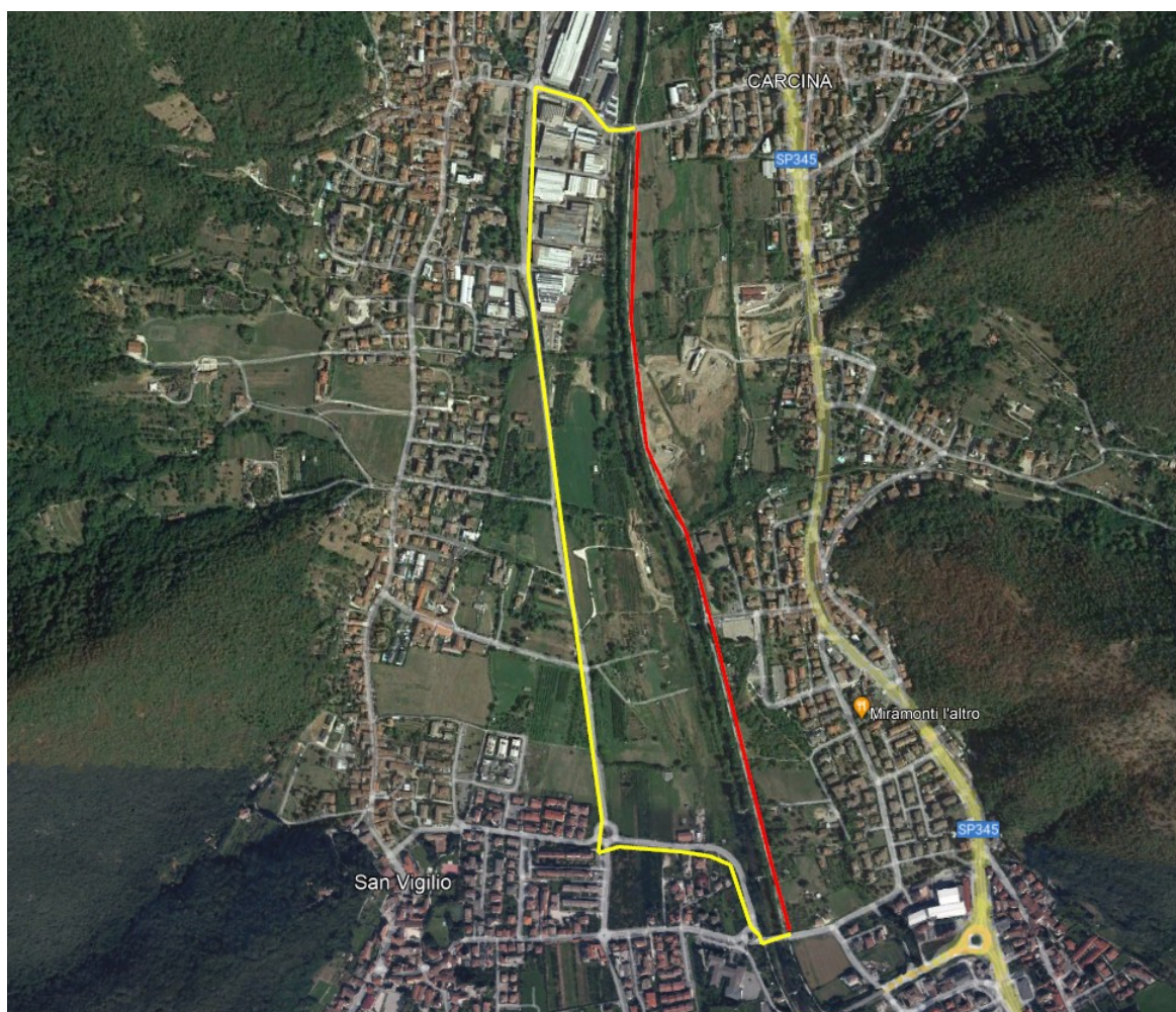
Fig. 1 Tratto 7 – by-pass (giallo) Villa Carcina-Concesio per l'interruzione della Greenway di Valle Trompia (rosso) dovuta ai lavori del Raccordo Autostradale
