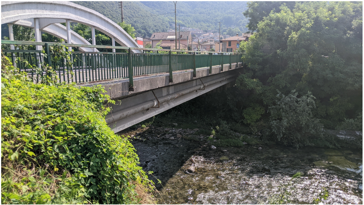
Fig. 8 Via D'annunzio: la rete SNAM staffata al ponte
