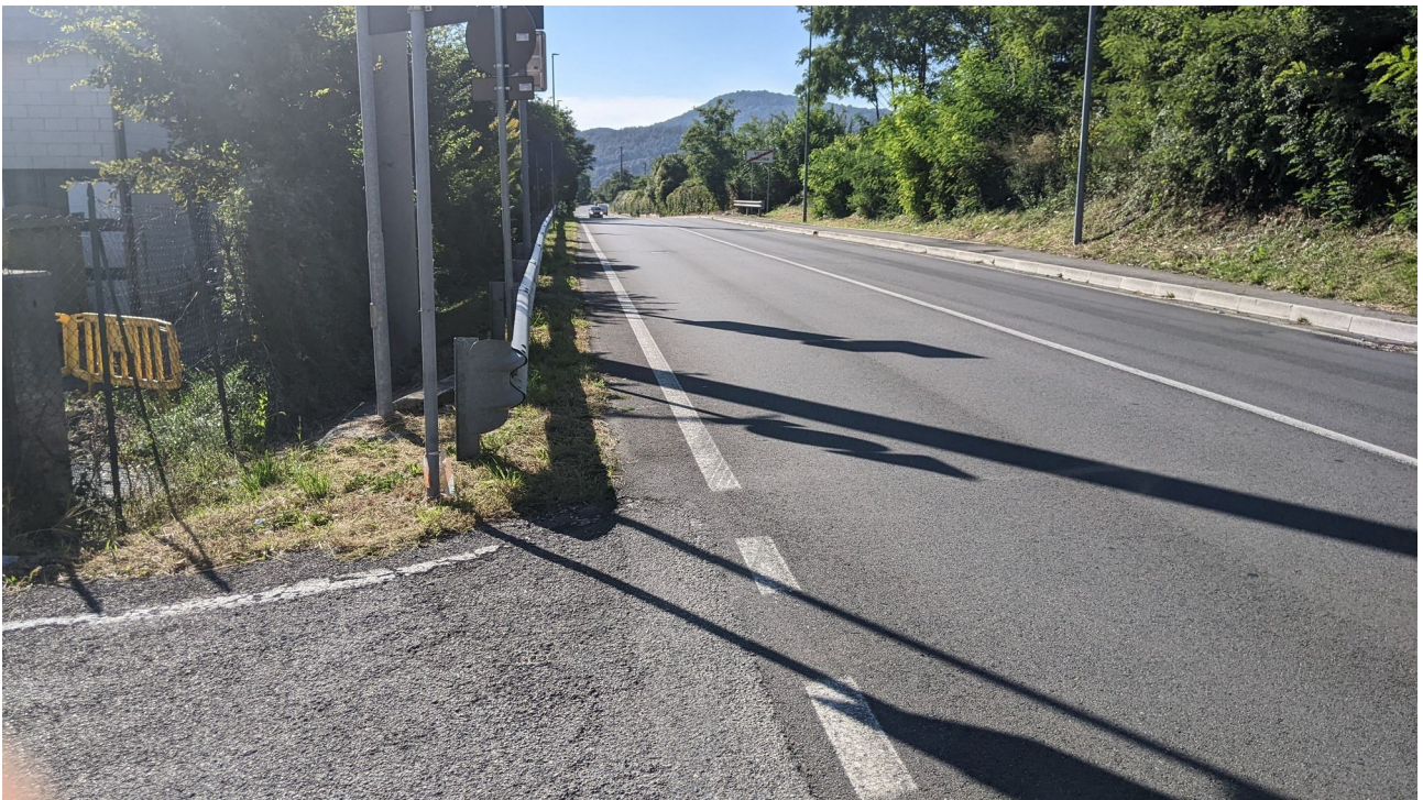
Fig. 16 Banchina esistente sul lato est di via Nicolini in prossimità del centro ecologico di Cailina; Per garantire l'allargamento per la corsia ciclabile e la visibilità necessaria sarà arretrato il guard-rail.
