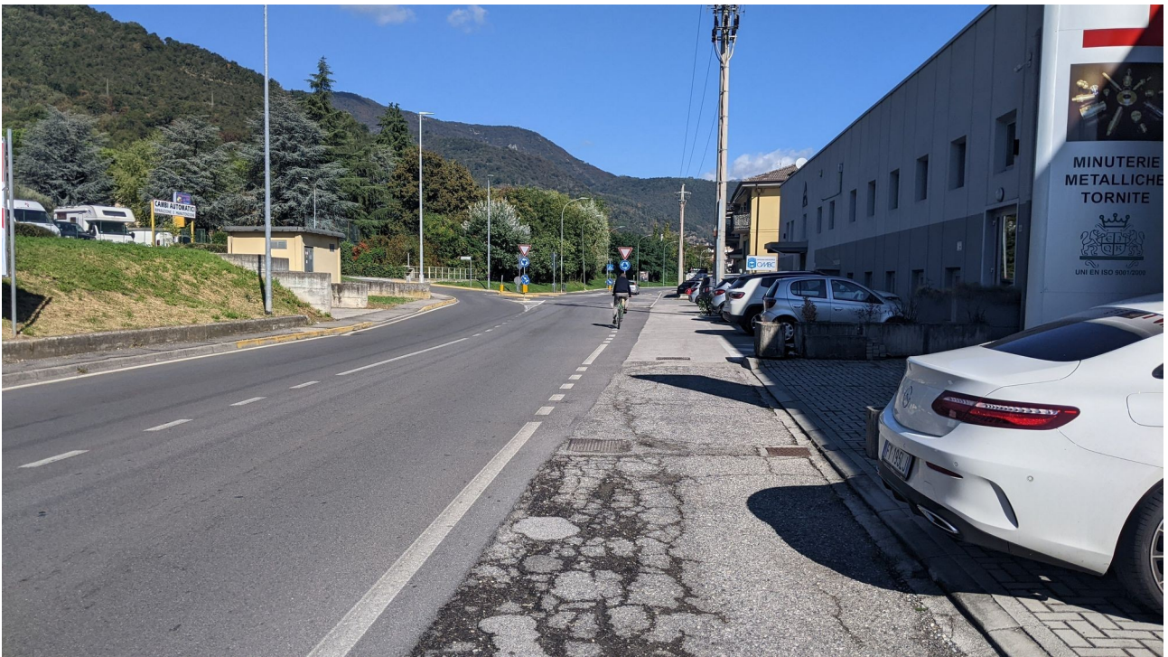
Fig. 18 Fascia tra corsia veicolare e parcheggi privata in cui sarà realizzata la nuova pista ciclopedonale a doppio senso (via Nicolini-via Sardegna)
