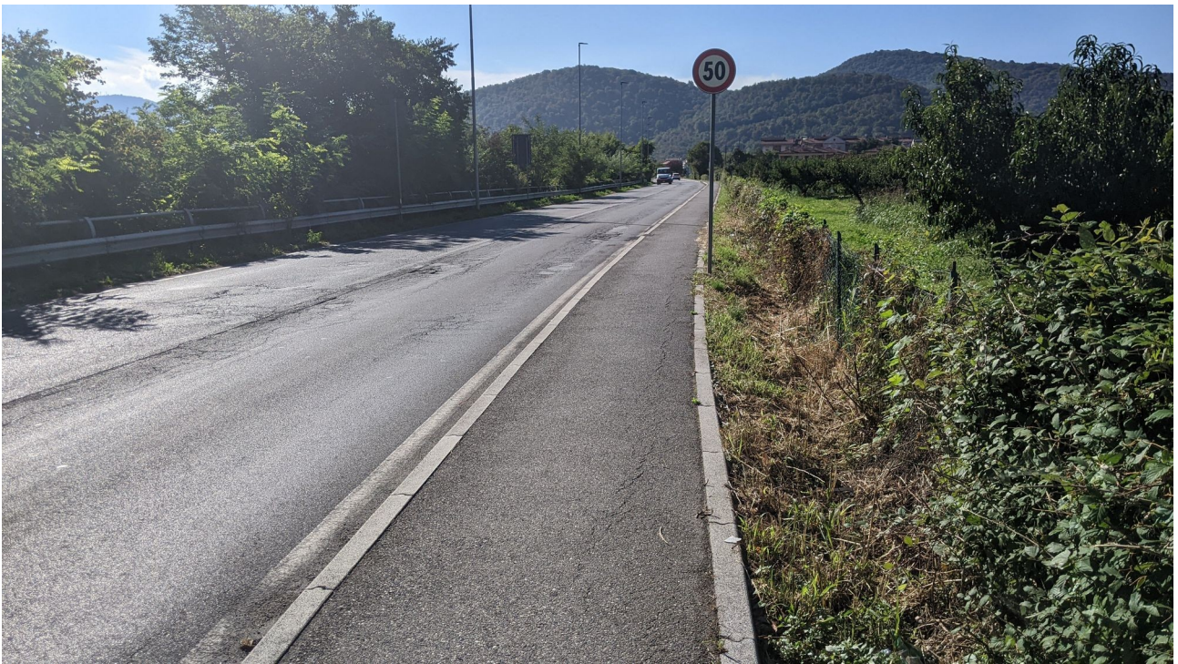
Fig. 14 Marciapiede esistente sul lato ovest di via Sorlini
