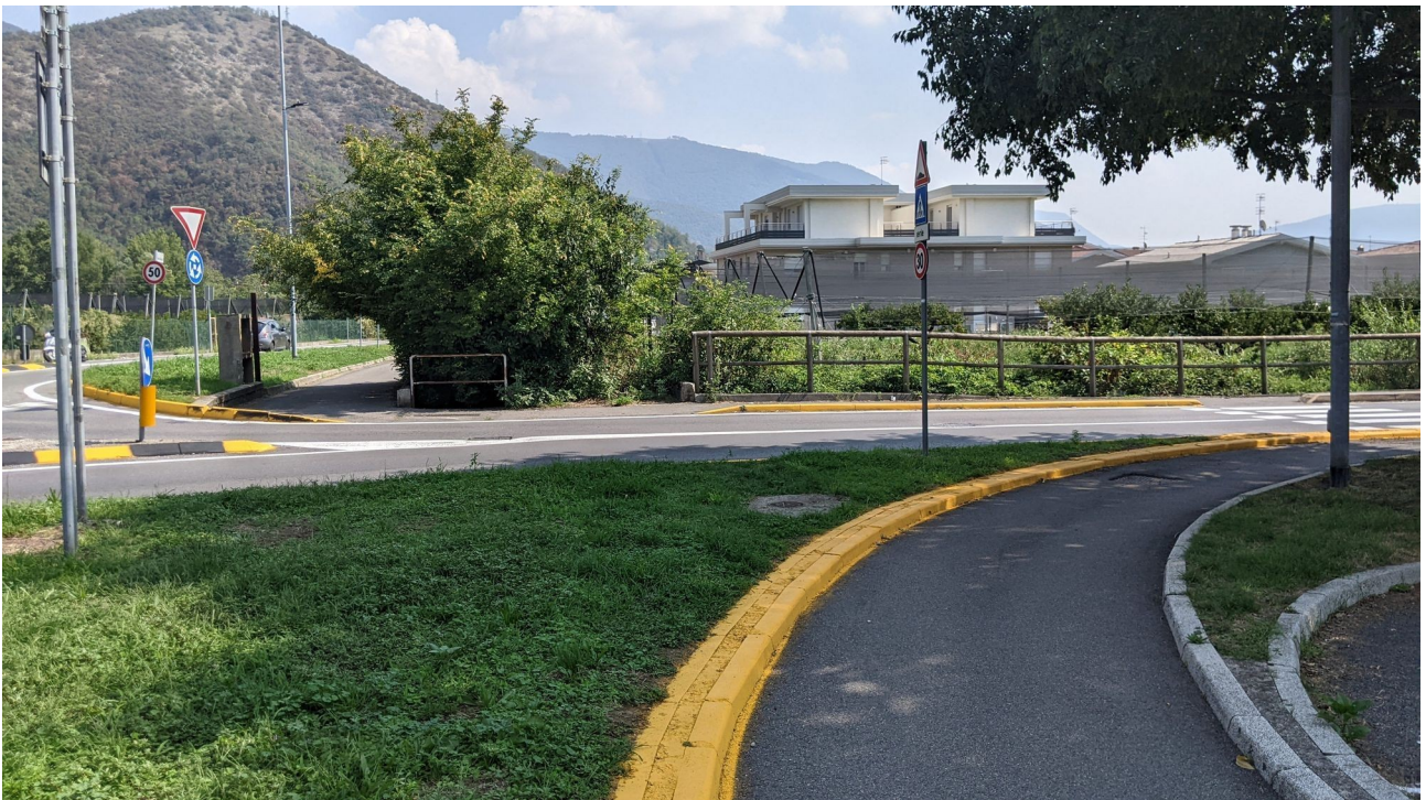
Fig. 10 Ciclopedonale nei pressi del ramo sud della rotatoria di via Galilei; l'attraversamento molto disassato (a destra) rende il tratto poco fruibile.
