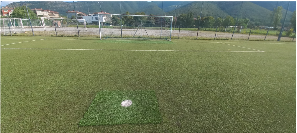
Vista fondo erboso sintetico ammalato/deteriorato
