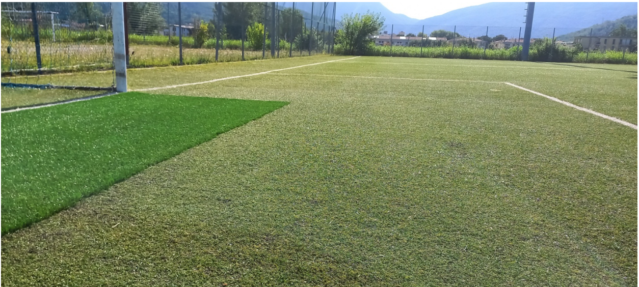
Vista fondo erboso sintetico ammalorato/deteriorato
