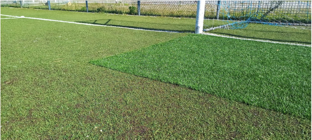
Vista fondo erboso sintetico ammalorato/deteriorato
