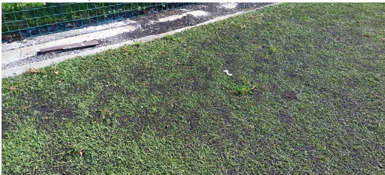
Vista raccolta canaletta perimetrale e fondo sintetico ammalorato
