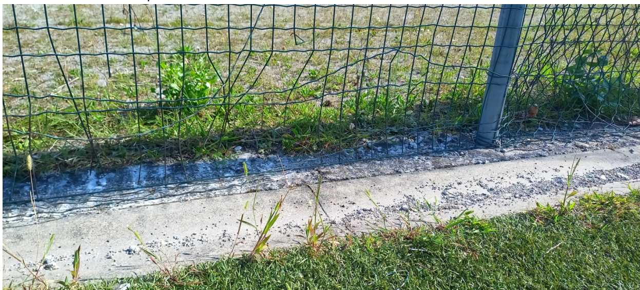
Vista raccolta canaletta perimetrale e fondo sintetico ammalorato
