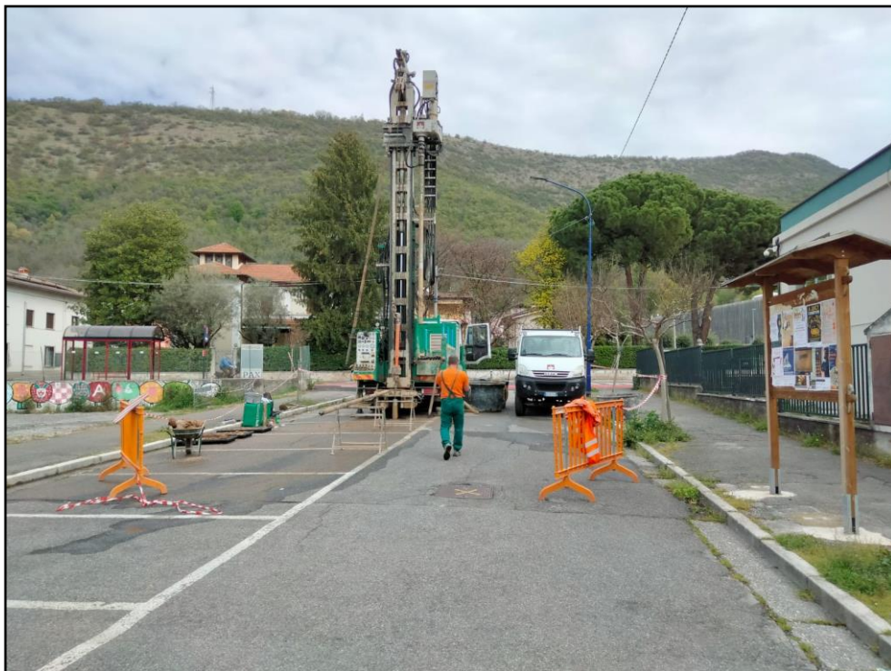
Foto 10 – Macchina perforatrice in manovra.
