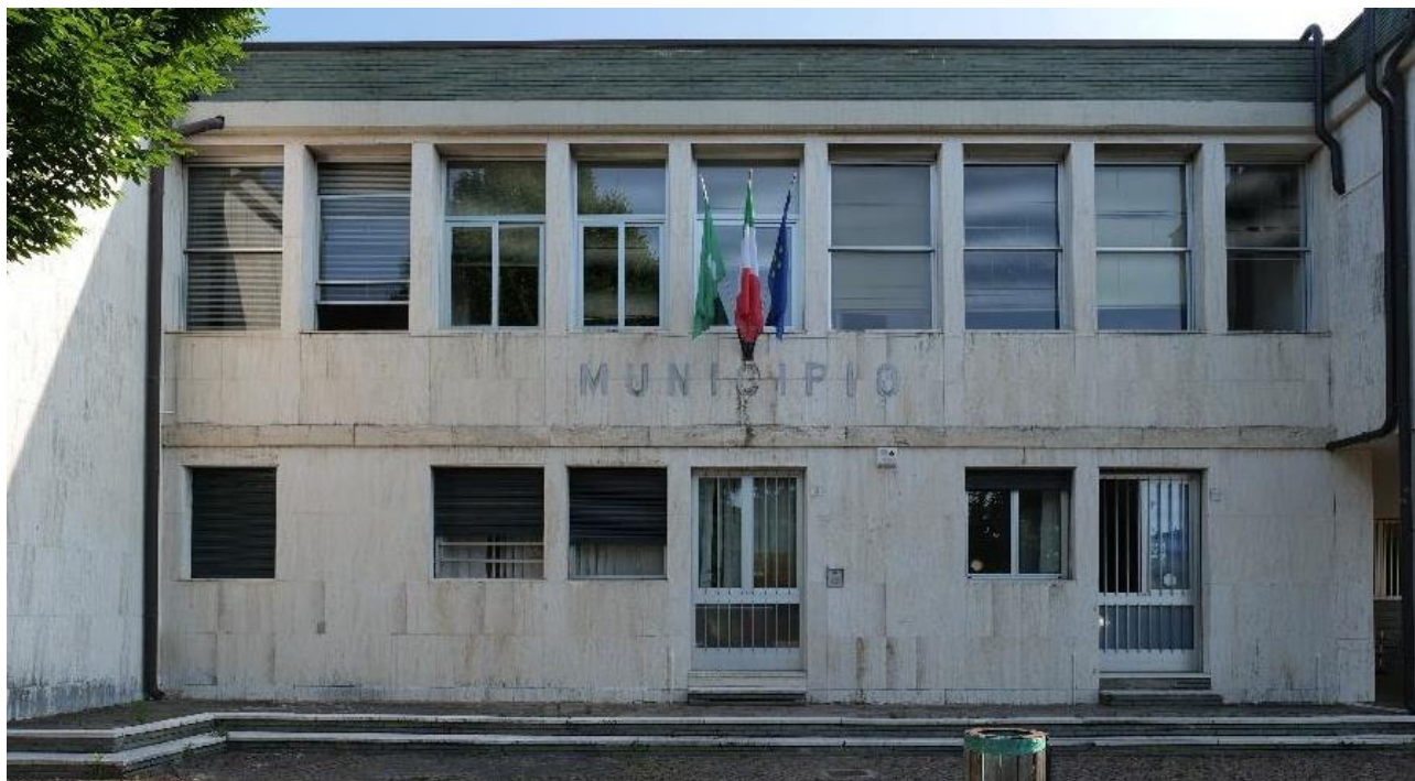
Particolare dell'ingresso del fabbricato a quota rialzata
