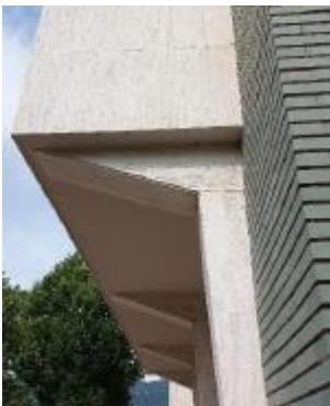
Particolare del rivestimento esterno in mattoncini
