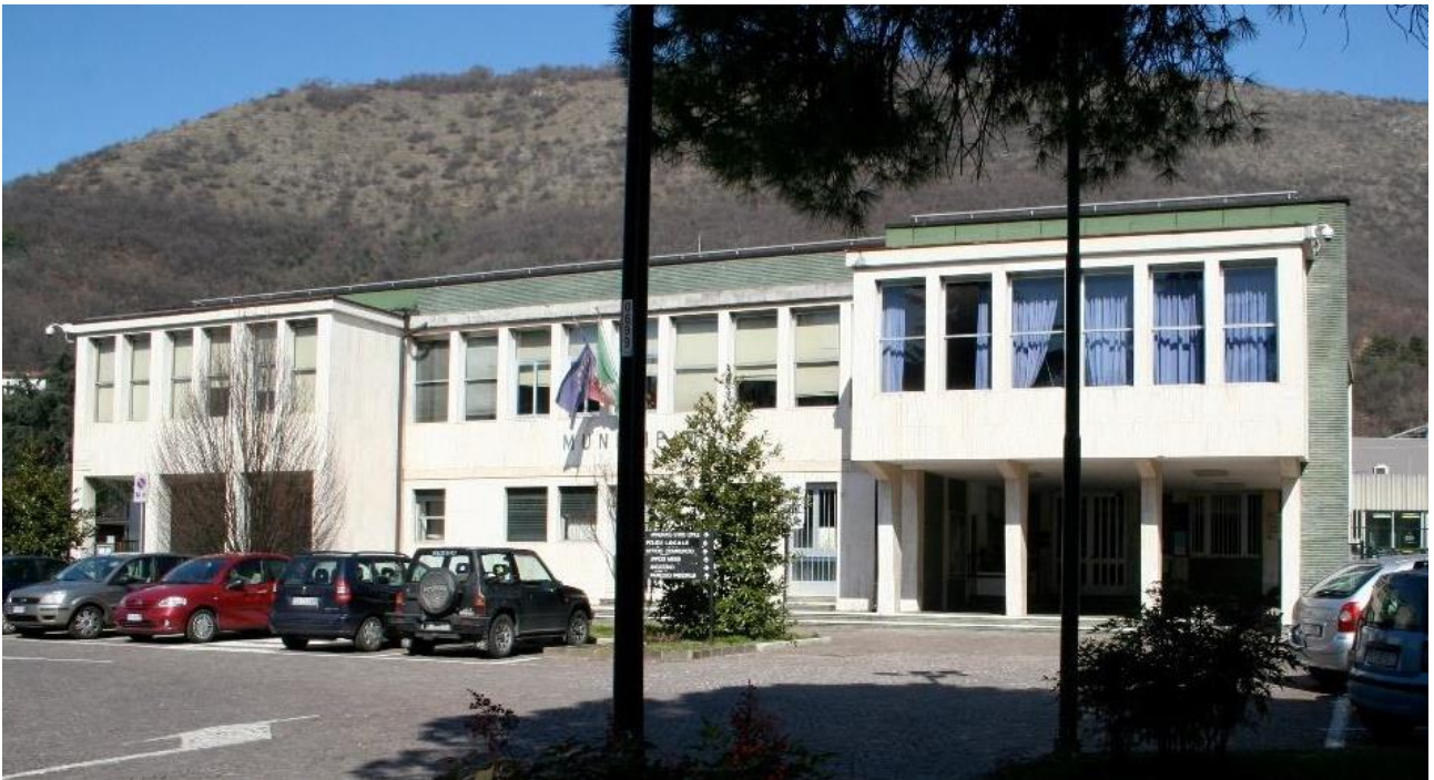
Fronte principale dell'attuale sede del Comune di Concesio
