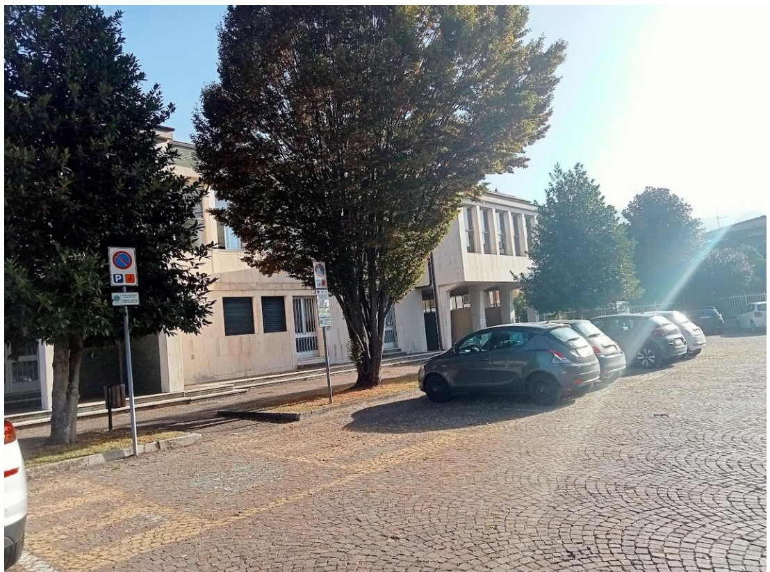
Piazzale prospiciente ingresso
