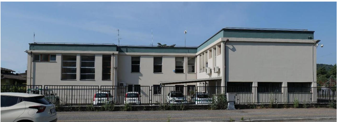
Fronte retrostante dell'attuale sede del Comune di Concesio
