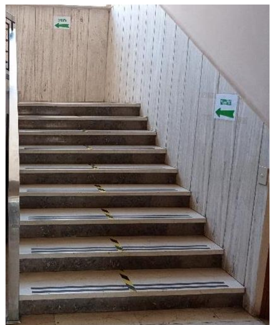
Dettaglio scala interna
