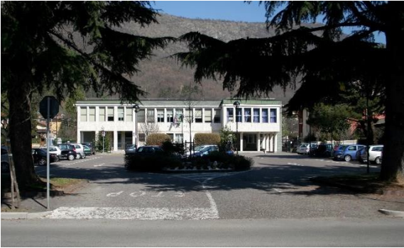
Facciata principale dell'attuale sede
