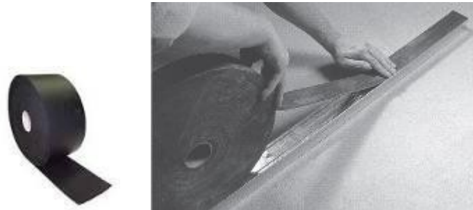
Figura n. 22: Posa della fascia taglia muro per sistemi a secco
