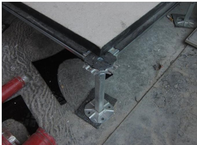
Figura n. 31: Posa della sottostruttura del pavimento sopraelevato
