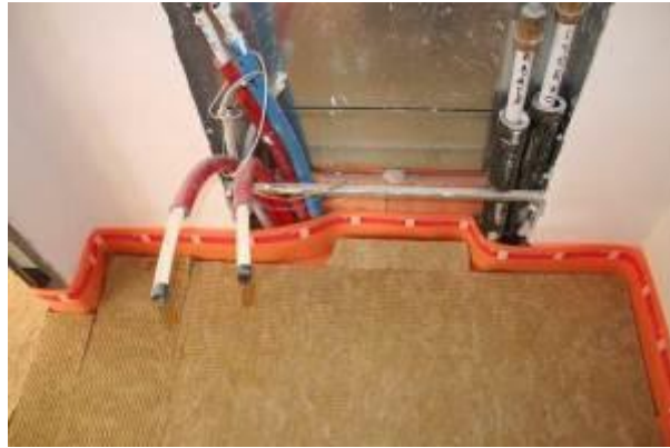
Figura n. 43 Foto della posa della banda perimetrale in corrispondenza del collettore
