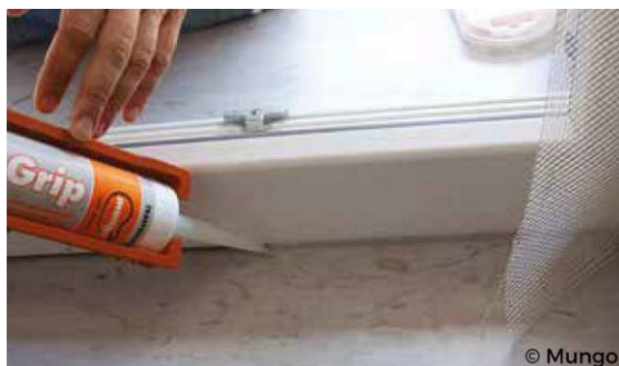
Figura n. 48: Esempio di sigillatura con silicone (Estratto catalogo società BigMat)
