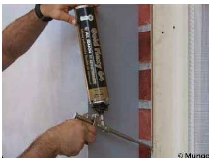
Figura n. 47: Esempio di riempimento con schiuma (Estratto catalogo società BigMat)
