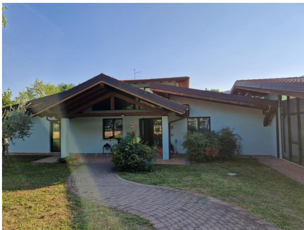
26-Ingresso asilo nido esistente
