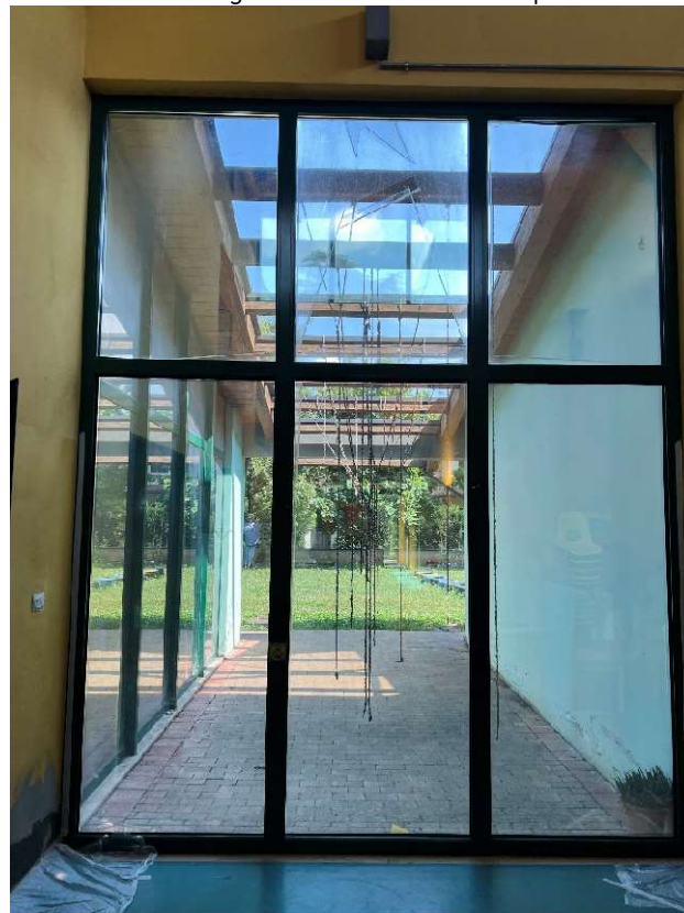
6-Patio – collegamento con futuro ampliamento
