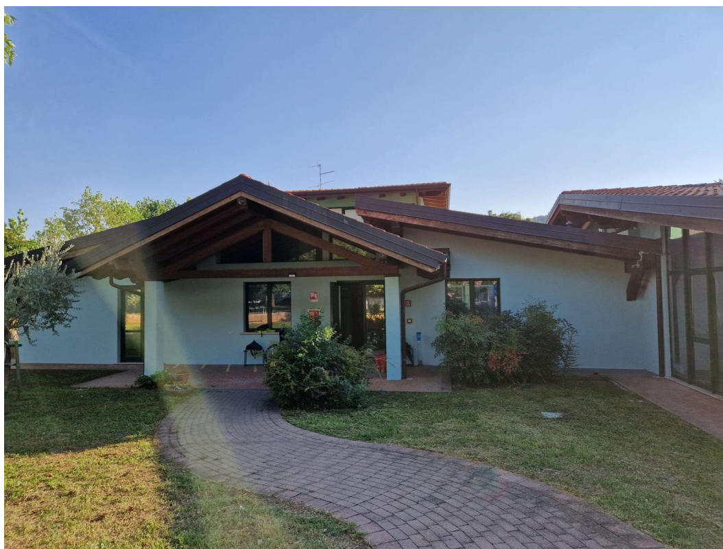
26-Ingresso asilo nido esistente
