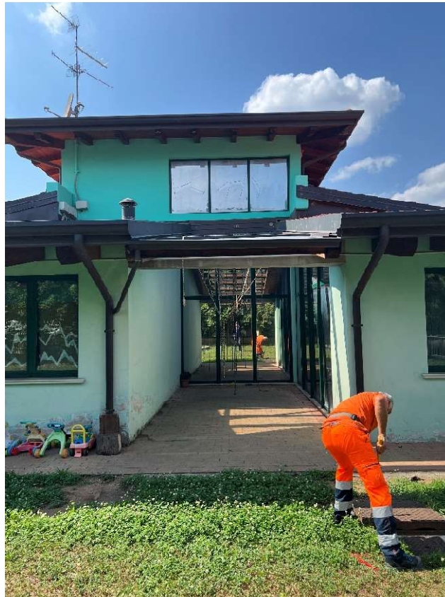
5-Patio – collegamento con futuro ampliamento
