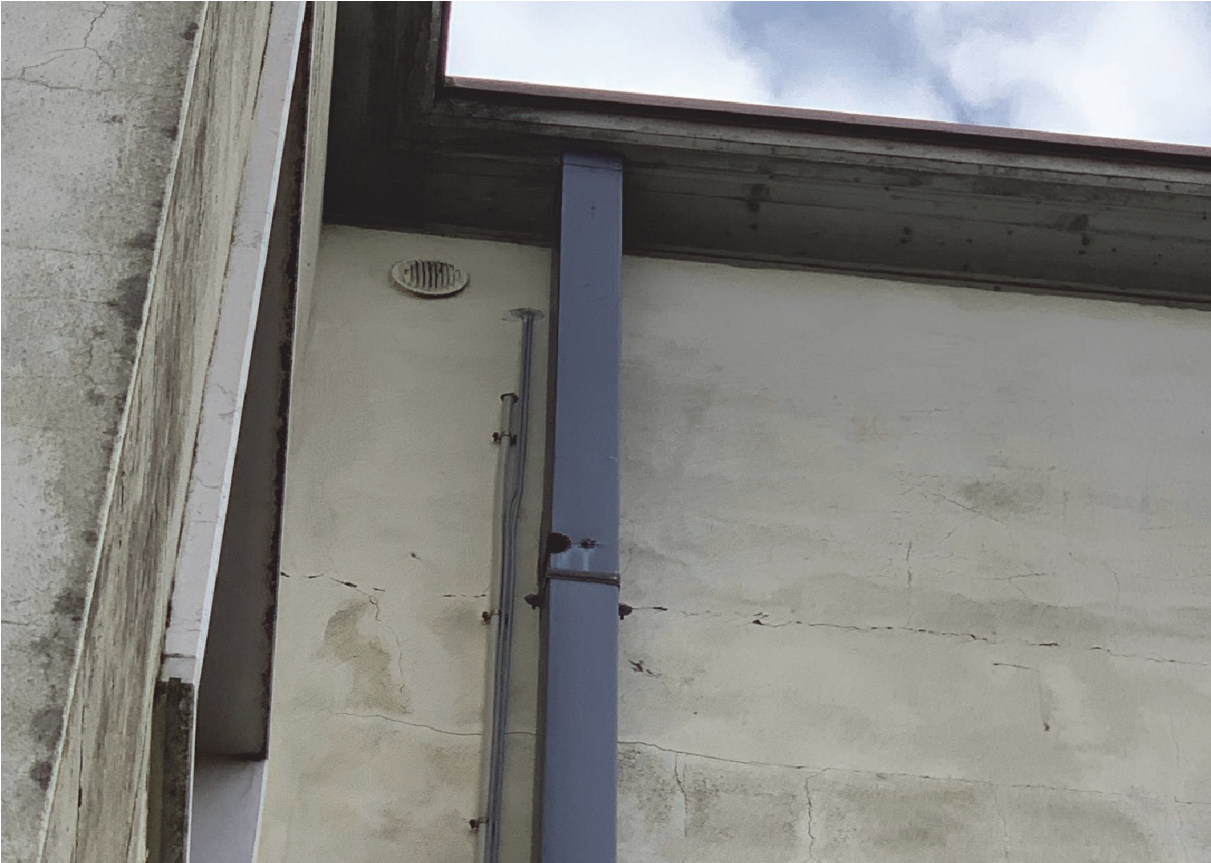
Pluviale ammalorato
