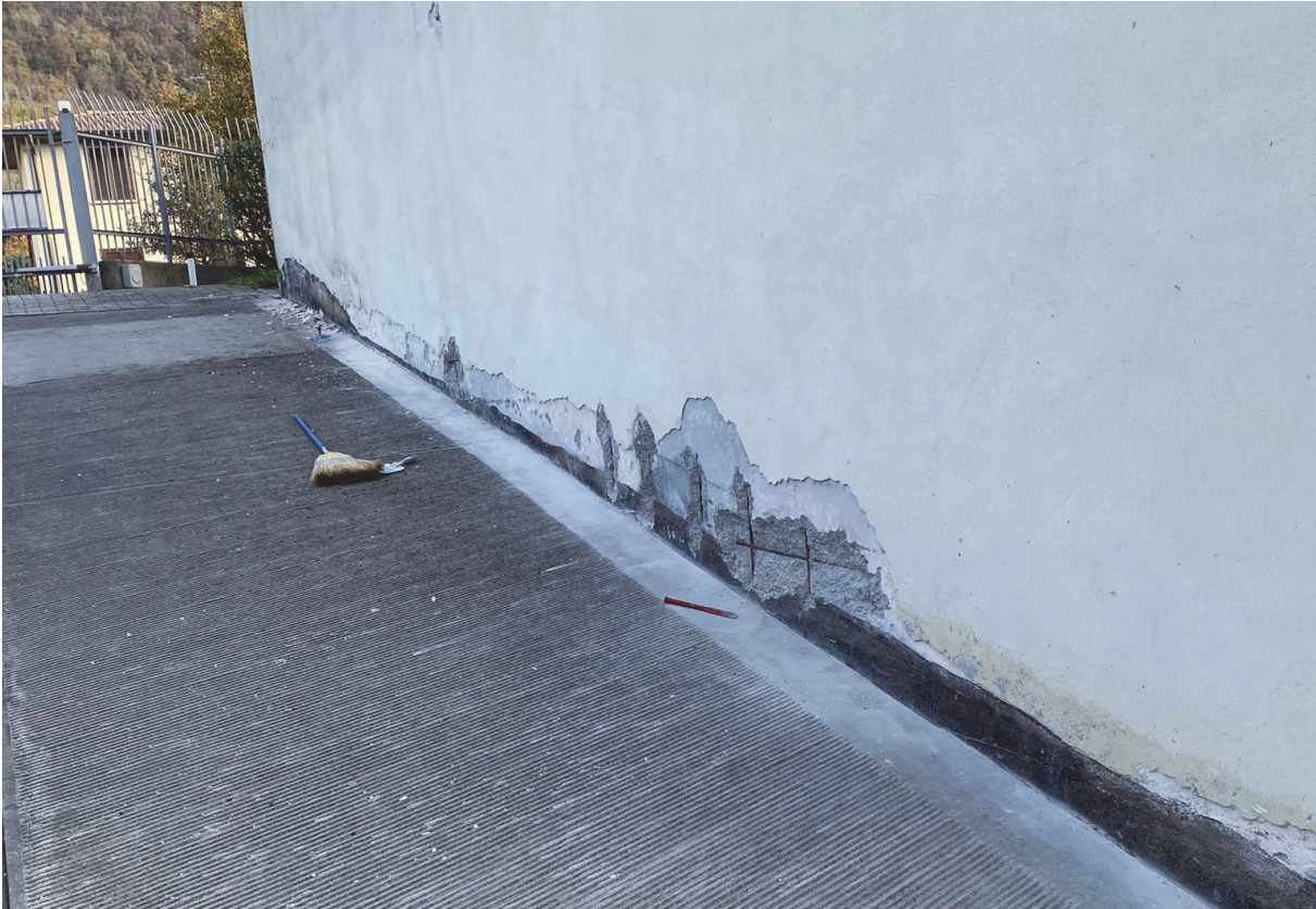
Scivolo in facciata ovest
