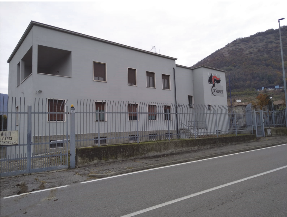
Vista dell'immobile da Via W. Tobagi
