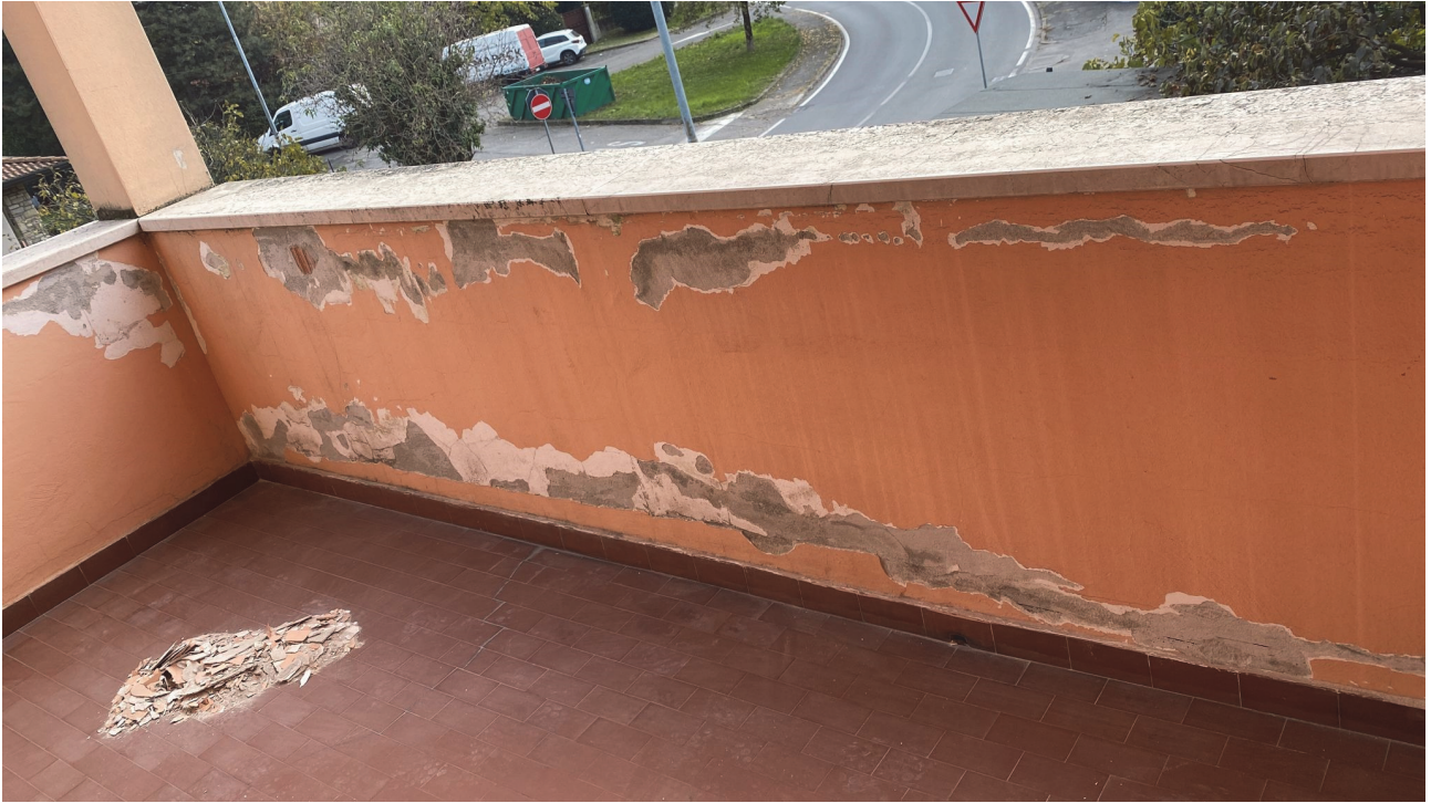
Parapetti della loggia sud
