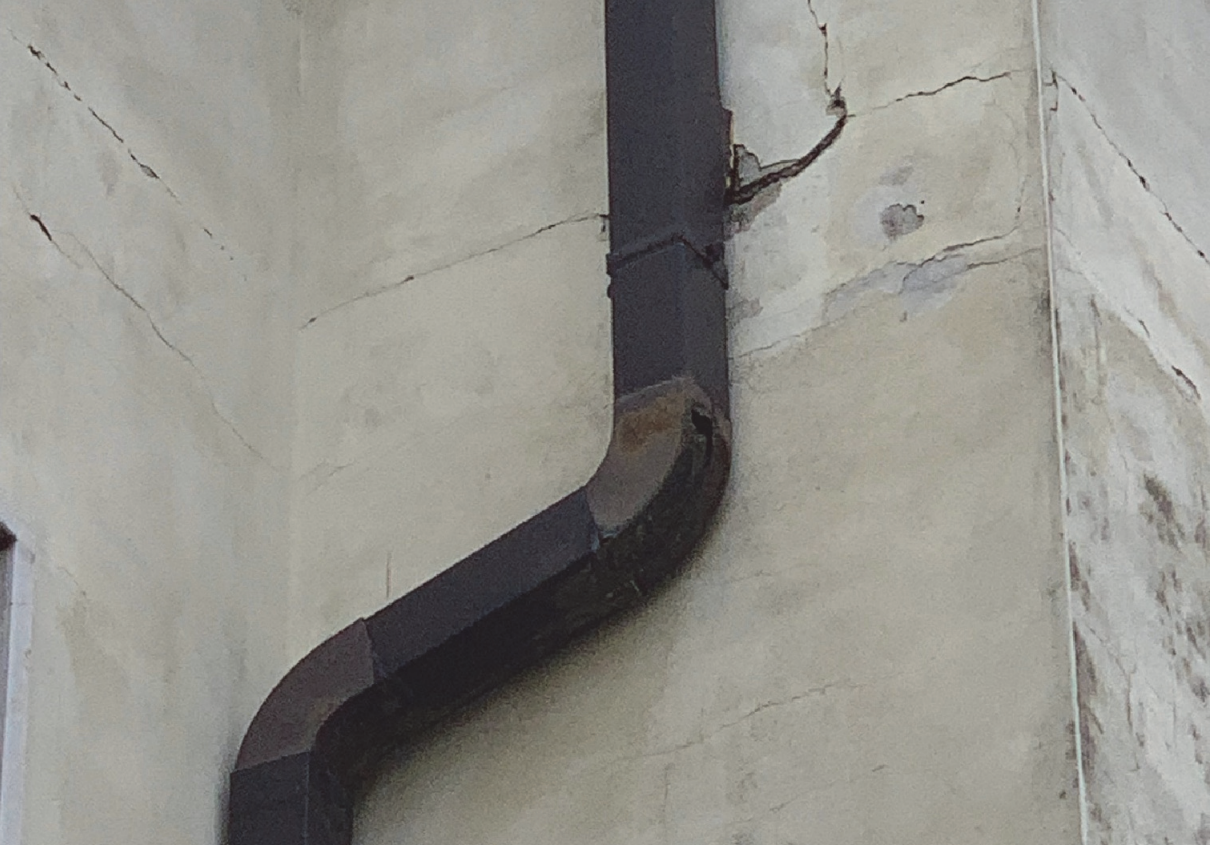
Pluviale ammalorato
