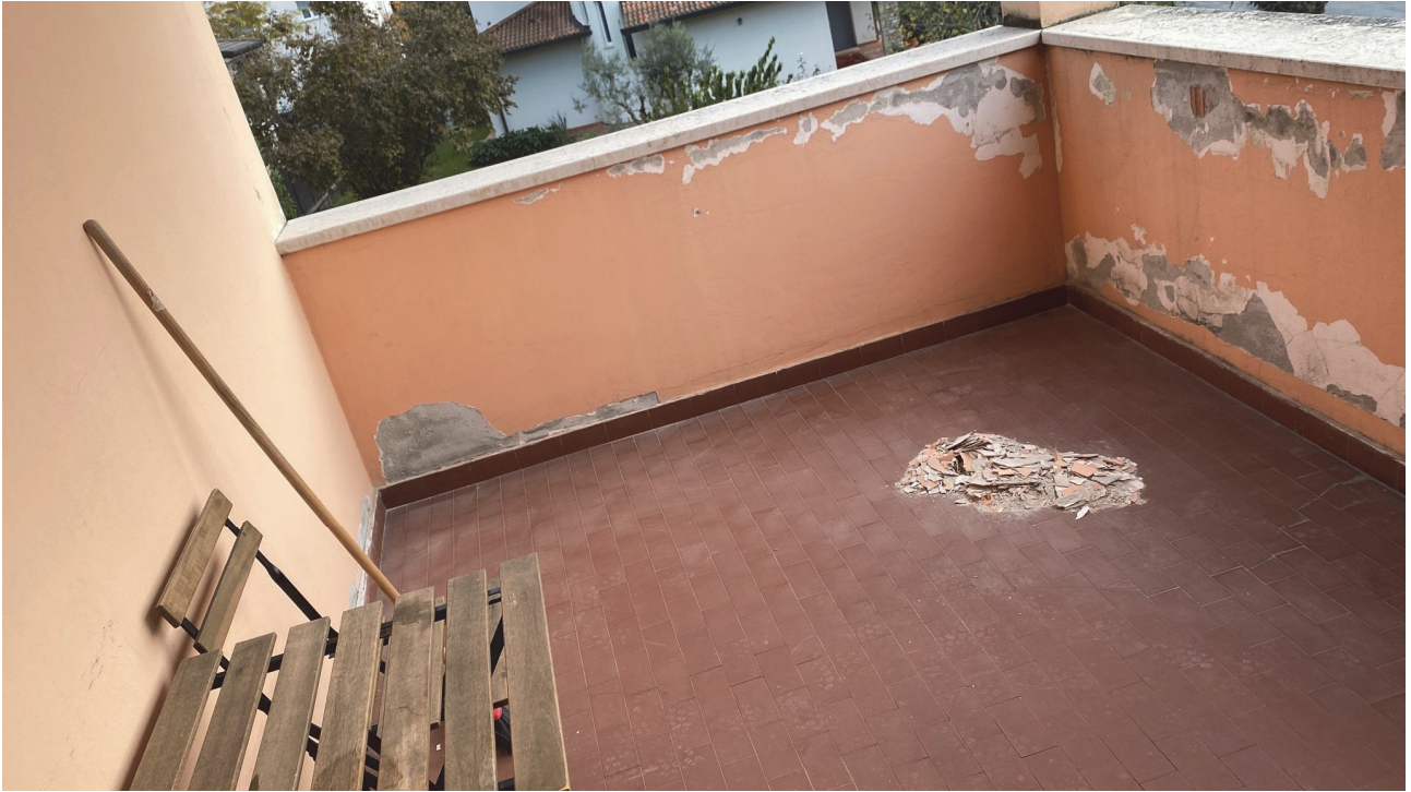
Parapetti della loggia sud
