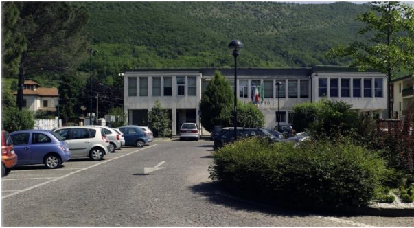
Facciata principale dell'attuale sede del Comune di Concesio
