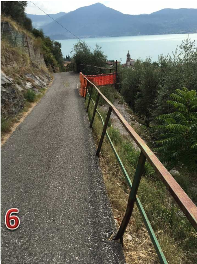
ACCESSO SECONDARIO A MONTE DELLA PROPRIETA'
