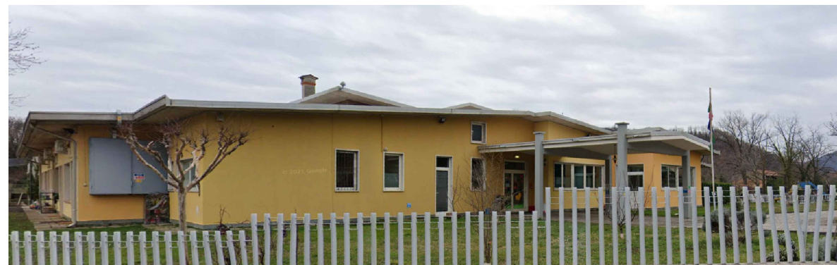
VISTA ESTERNA DELLA SCUOLA MATERNA
