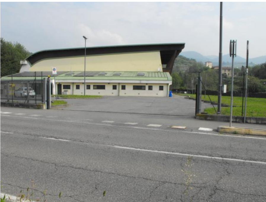
Fot. 2: ingresso parcheggio antistante il palazzetto dello sport
