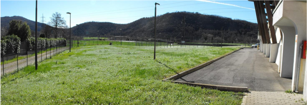
Fot. 6: area di cantiere vista da nord
